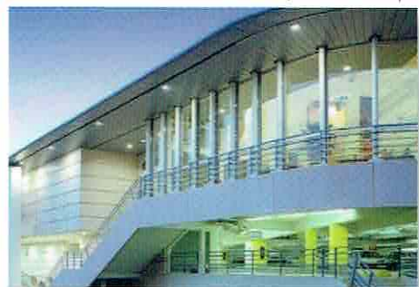
Auchan de Grasse 10 000 m 2 - THERMIQUE en site occupé
